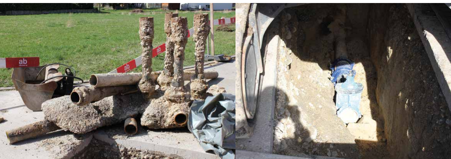
Altes Kreuz: alte Trinkwasserleitungen aus Gusseisen mit Schiebern in die 4 Richtungen Baselweg hoch und runter – Kreuzmattweg – Geissackerweg
